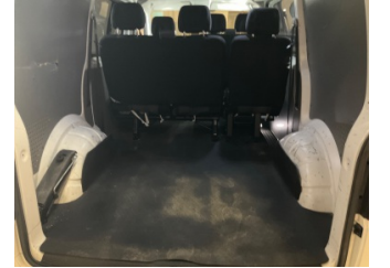
Döşemeler/Kapaklar, Döşemeler/Kapaklar > Deforme Olmuş
