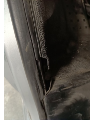
Döşemeler/Kapaklar, Döşemeler/Kapaklar > Hasarlı
