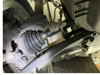
Ön aks, Aks mili, sağ > Yağ Kaçağı
