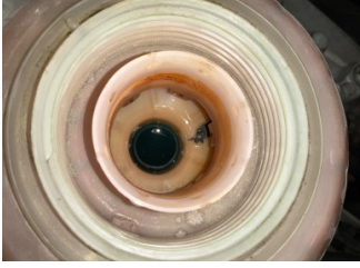
Motorsoğutması, Soğutma sıvısı > Kirlenmiş
