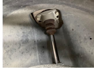
Arka aks, Amortisör körüğü, sol > Hasarlı
