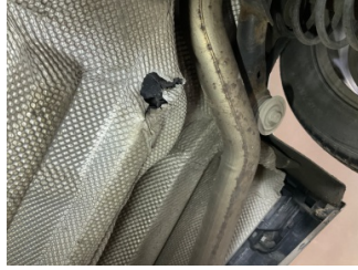
Kaporta, Muhafaza, arka > Hasarlı
