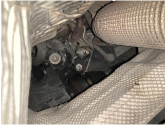
Motor, Motor > Yağ Kaçağı
