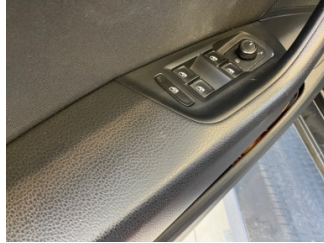
Döşemeler/Kapaklar, Döşemeler/Kapaklar > Yakıcı Madde ile Zarar Görmüş
