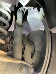
Arka aks, Amortisör, arka sağ > Yağ Kaçağı
