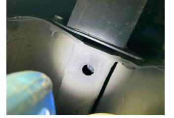
Arka bölüm, Arka sac/panel > Hasarlı
