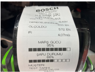
Elektrik donanımı/Pano, Akü > Test Sonucu
