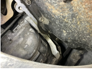
Motor, Motor > Yağ Kaçağı
