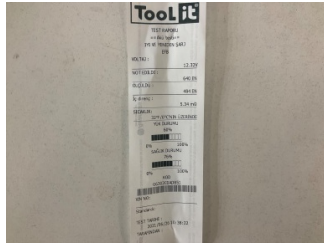
Elektrik donanımı/Pano, Akü > Test Sonucu
