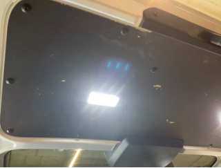
Döşemeler/Kapaklar, Döşemeler/Kapaklar > Çizik
