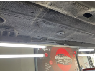
Kaporta, Araç gövdesi altı, ön > Hasarlı
