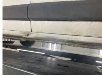
Marşbiyel, sağ, Marşbiyel, sağ > Hasarlı
