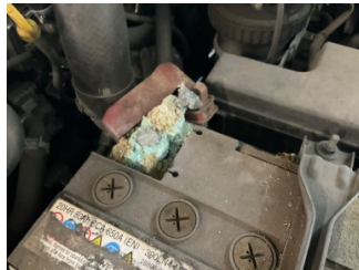
Elektrik donanımı/Pano, Akü > Onaysız
