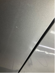
Kapı, sol ön, Kapı, sol > Ezik
