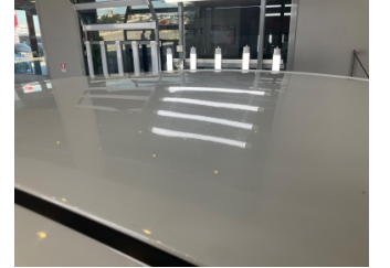
Tavan, Tavan > Dolu Hasarı
