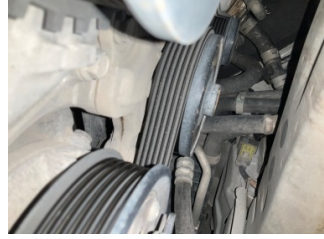
Motorsoğutması, Kayış > Çatlak
