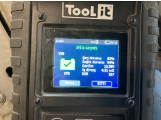
Elektrik donanımı/Pano, Akü > Test Sonucu
