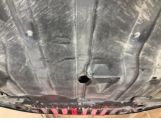
Motor, Alt muhafaza > Hasarlı
