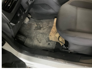
Taban, Paspaslar > Hasarlı
