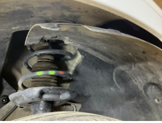
Çamurluk, sağ, Davlumbaz > Sabitlemesi Hatalı
