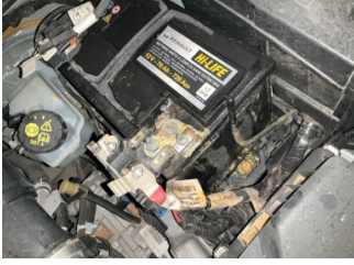
Elektrik donanımı/Pano, Akü > Onaysız
