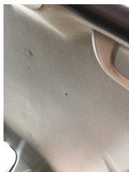
Döşemeler/Kapaklar, Tavan döşemesi > Yakıcı Madde Ile Zarar Görmüş
