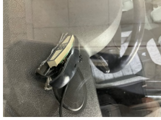
Elektrik donanımı/Pano, Park asistanı > Kırılmış
