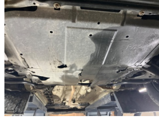
Motor, Alt muhafaza > Hasarlı
