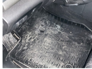
Taban, Paspaslar > Hasarlı
