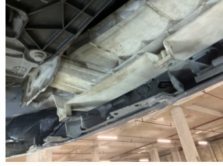
Tampon, arka, Bağlantı ayağı > Hasarlı
