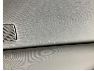
Döşemeler/Kapaklar, Tavan döşemesi > Çizik
