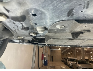
Motor, Alt muhafaza > Hasarlı
