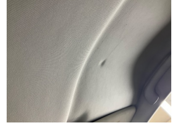
Döşemeler/Kapaklar, Tavan döşemesi > Deforme Olmuş
