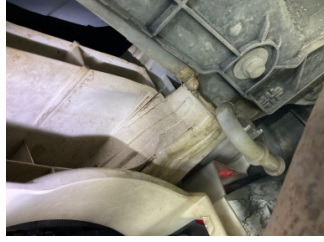
Tampon, arka, Bağlantı ayağı > Kırılmış
