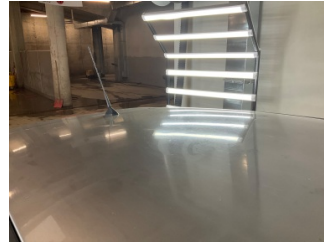
Tavan, Tavan > Dolu Hasarı
