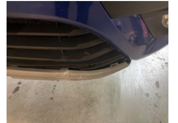
Tampon, ön, Spoiler > Hasarlı
