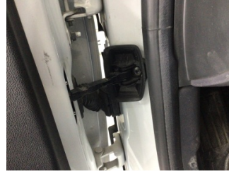
Kapı, sol ön, Kapı gergisi > Ses Yapıyor
