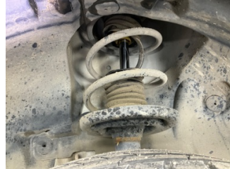
Ön aks, Amortisör körüğü, sol > Hasarlı
