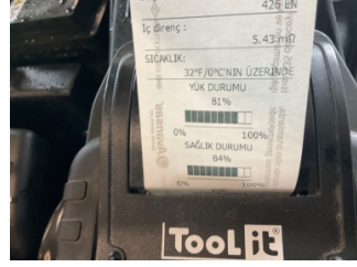
Elektrik donanımı/Pano, Akü > Test Sonucu
