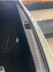
Döşemeler/Kapaklar, Döşemeler/Kapaklar > Çizik
