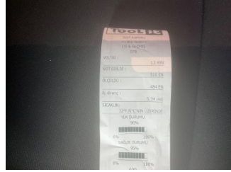
Elektrik donanımı/Pano, Akü > Test Sonucu
