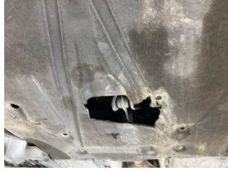
Motor, Alt muhafaza > Hasarlı
