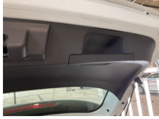
Döşemeler/Kapaklar, Bagaj kapağı, iç döşemesi > Sabitlemesi Hatalı
