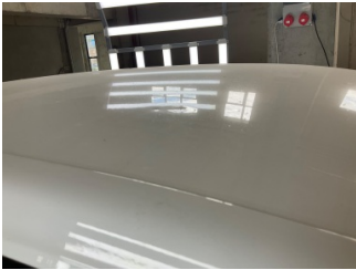
Tavan, Tavan > Dolu Hasarı
