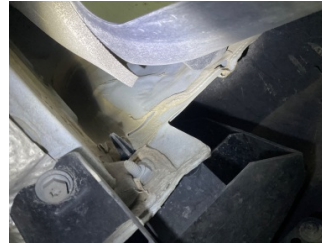
Arka bölüm, Arka sac/panel > Hasarlı
