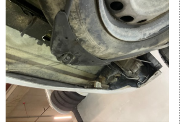
Elektrik donanımı/Pano, Kablo demeti > Onaysız
