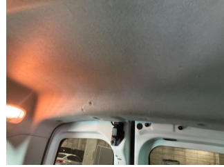
Döşemeler/Kapaklar, Döşemeler/Kapaklar > Deforme Olmuş
