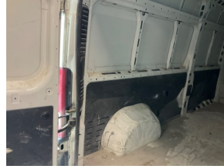
Döşemeler/Kapaklar, Döşemeler/Kapaklar > Çizik
