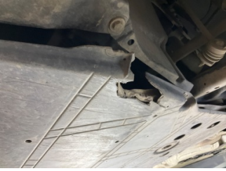
Motor, Alt muhafaza > Hasarlı
