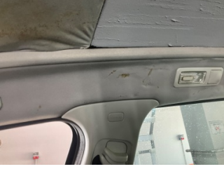
Döşemeler/Kapaklar, Döşemeler/Kapaklar > Hasarlı
