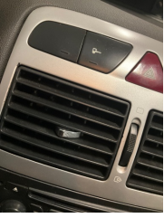
Kalorifer/Klima, Havalandırma ızgarası > Hasarlı
