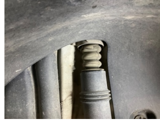
Arka aks, Amortisör körüğü, sağ > Hasarlı
